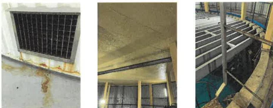
Suite à ces constats, des tests sur le système de ventilation forcée, incluant le passage de l'extraction à l'insufflation et des variations de vitesse, ainsi que le nettoyage des équipements corrodés, ont été réalisés, sans amélioration significative.
